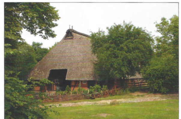
Abstützung der rückwärtigen Giebelwand des Spiekerhus
