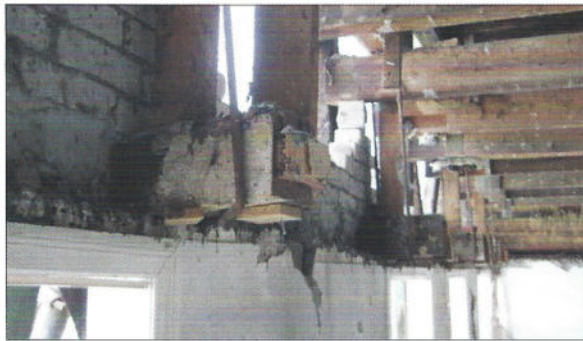
Abb. 6: Ansicht des Rückgiebels nach den Renovierungsarbeiten im Sommer 2010 (*/15)
