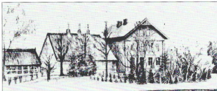
Mittlerer Gebäudeteil: Das Volksdorfer Schulhauses von 1830-1891, rechts der Neubau
