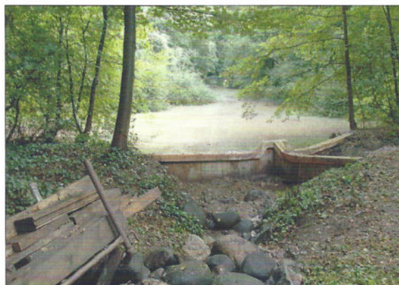
Neues Wehr am Krintendick
