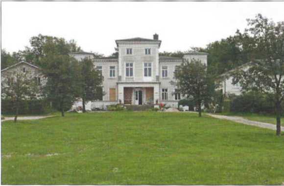
Das Gutsgebäude, das zur Zeit saniert wird. Über die frühere Geschichte des Guts ist im Jahrbuch 2010 des Alstervereins ein längerer Artikel erschienen.
