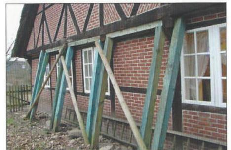
Bausünden aus den 1960er Jahren: Die rückwärtige Wand des Spiekerhus drohte abzurutschen und musste gestützt werden.
